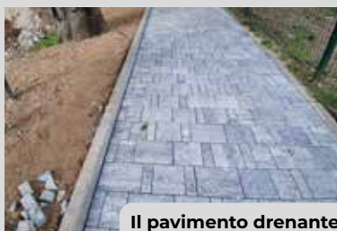
Il pavimento drenante
